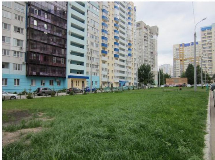
Фото объекта «До»
