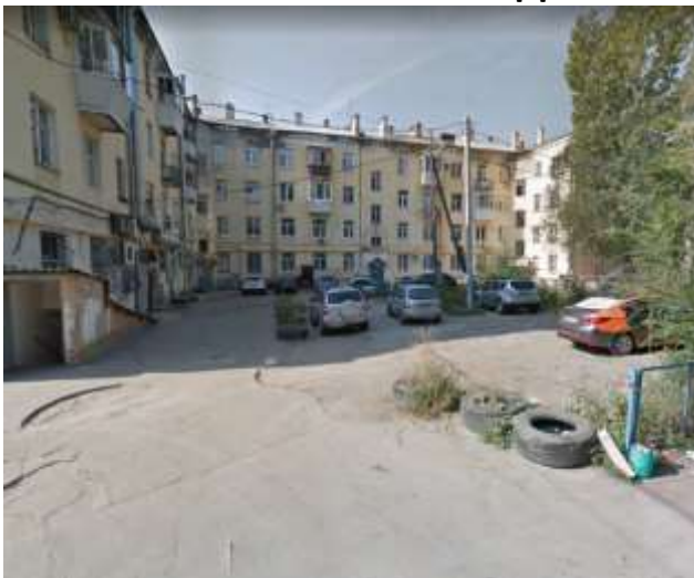
Фото объекта «ДО»
